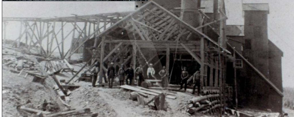
Usine de traitement du manganèse à Dawson Settlement, où le manganèse de marais était séché, comprimé et façonné en briquettes, vers 1899. Gracieuseté de John Whitmore, Hillsborough (N.-B.)
