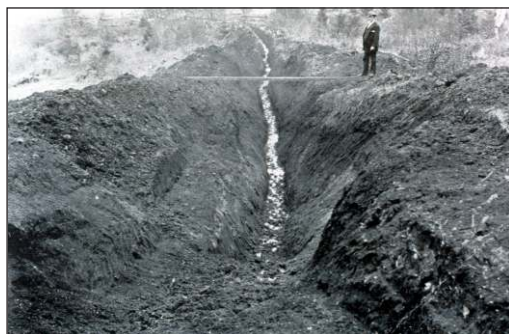
Drainage de l'eau d'un gisement de manganèse de marais à Dawson Settlement, dans le Sud-Est du Nouveau-Brunswick, vers 1898. Bailey, 1899
