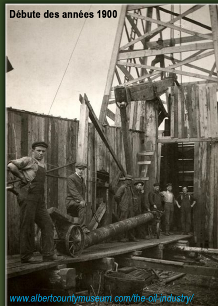
Appareil de forage au câble dans le champ de Stoney Creek
