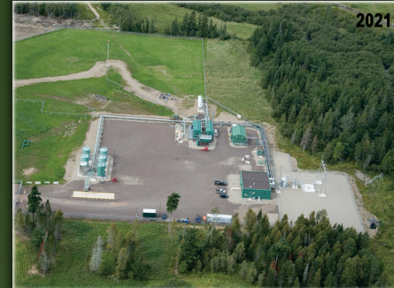
Installation de traitement de gaz naturel du champ McCully
