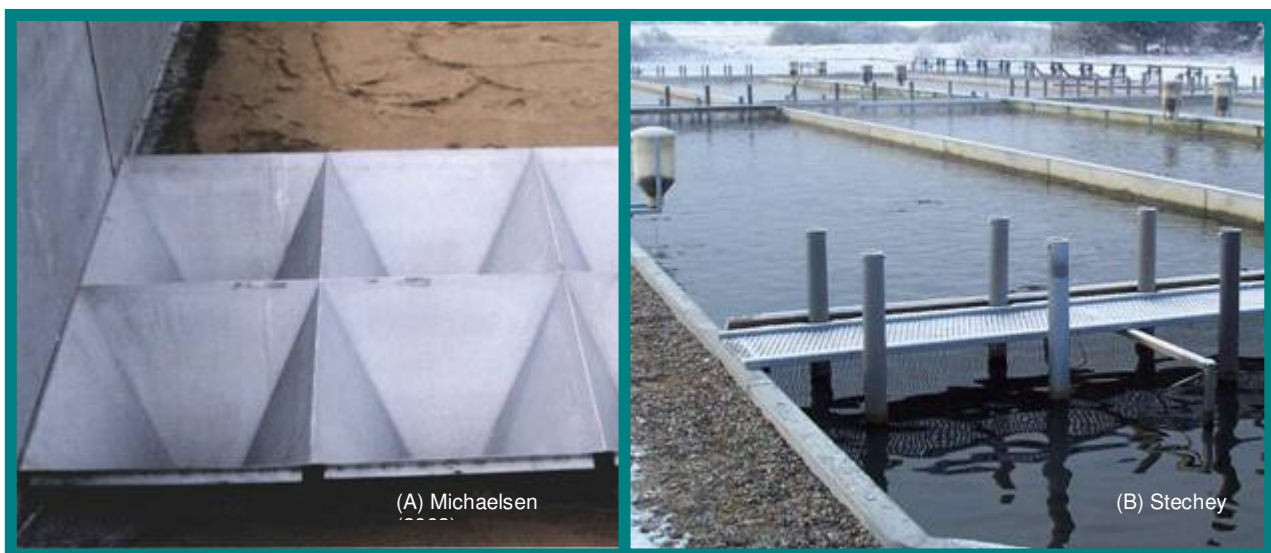
Figure 11: Cônes boues en cours d'installation dans un bassin (A). Tubes de levage dépassant des cônes à boues dans un bassin allongé de béton design danois (B)
