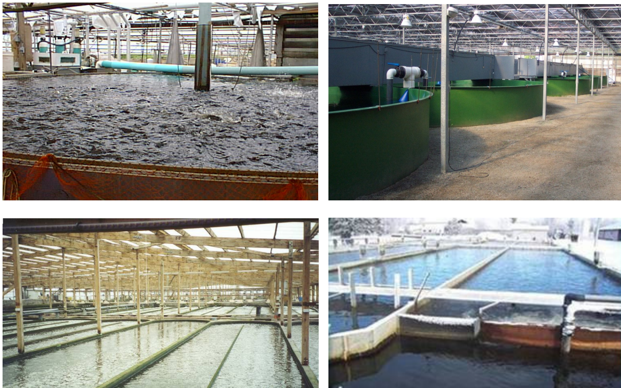
Figure 6: Exemples de bassins circulaires et des bassins allongés de béton utilisés en aquaculture intensive.
